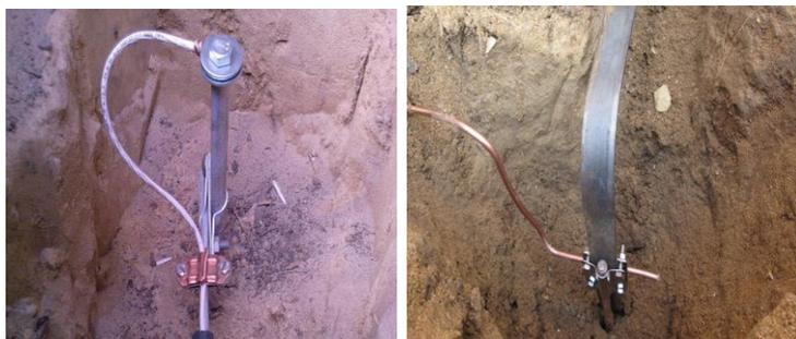
Рис. 3.9. Устройство траншейной установки вертикальных электродов
