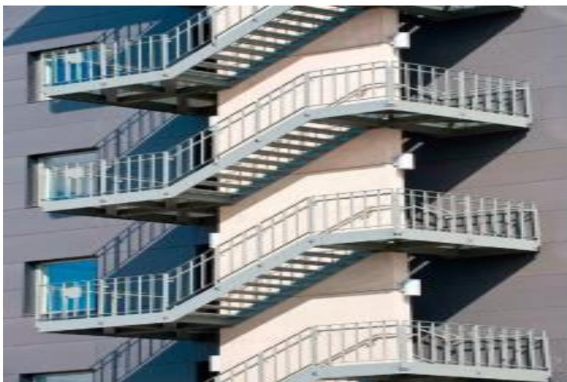
Рис. 5.3. Пожарная лестница многоэтажного здания
