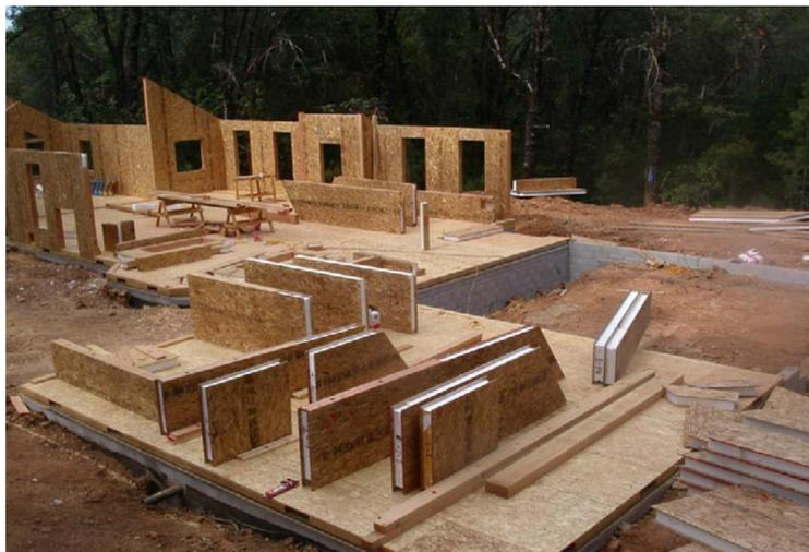
Рис. 5.6. Основные изоляционные панели зданий
